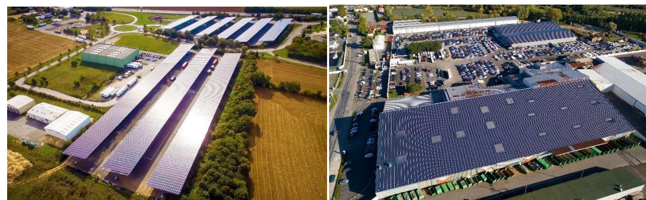
Figure 5 : Ombrières à gauche et panneaux en toiture à droite (Deux-Sèvres).
